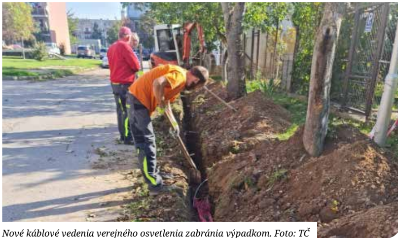
Nové káblové vedenia verejného osvetlenia zabráni výpadkom. Foto: TČ
