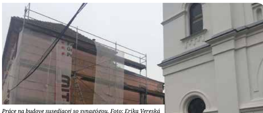
Práce na budove susediacej so synagógou. Foto: Erika Vereská
