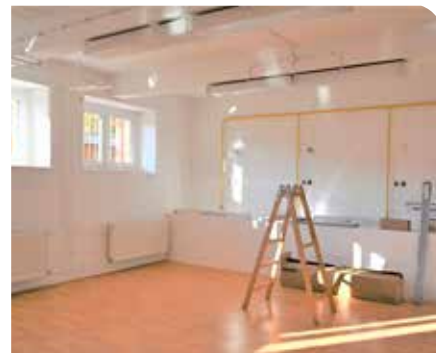
Jayzková učebňa počas rekonštrukcie. Foto: VCs.
