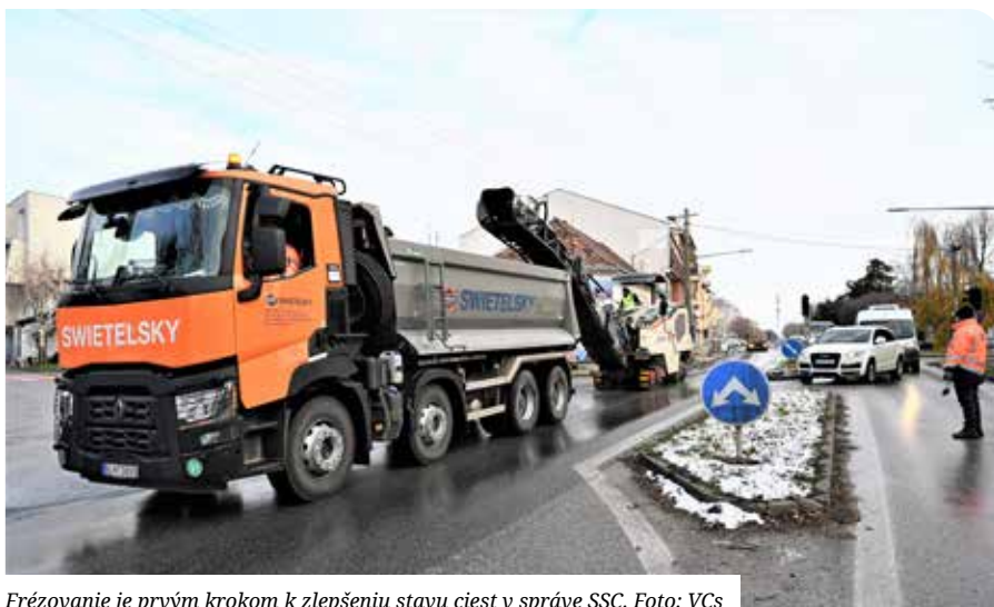
Frézovanie je prvým krokom k zlepšeniu stavu ciest v správe SSC. Foto: VCS
