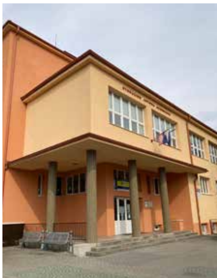
Budova školy na Lichnerovej ulici. Foto: MO
