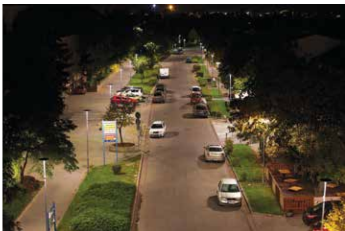
Osvetlenie pešej zóny Lichnerova po modernizácii. Foto: DK
