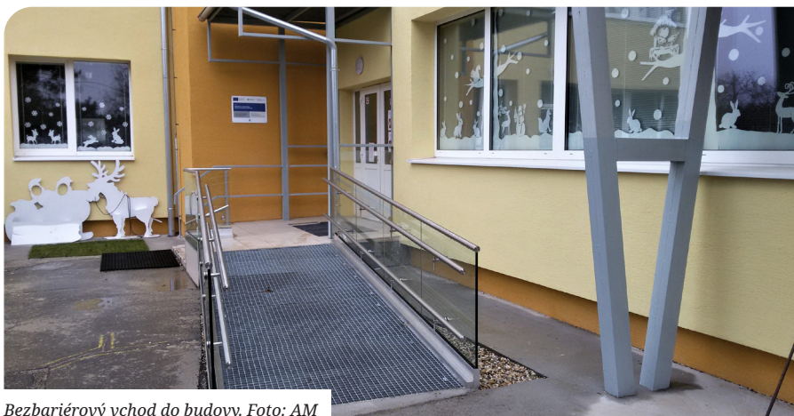
Bezbariérový vchod do budovy. Foto: AM
