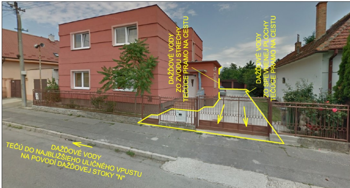
Obr. č.14 – Príklad nesprávneho odvedenia dažďových vôd od rodinného domu v meste Senec
