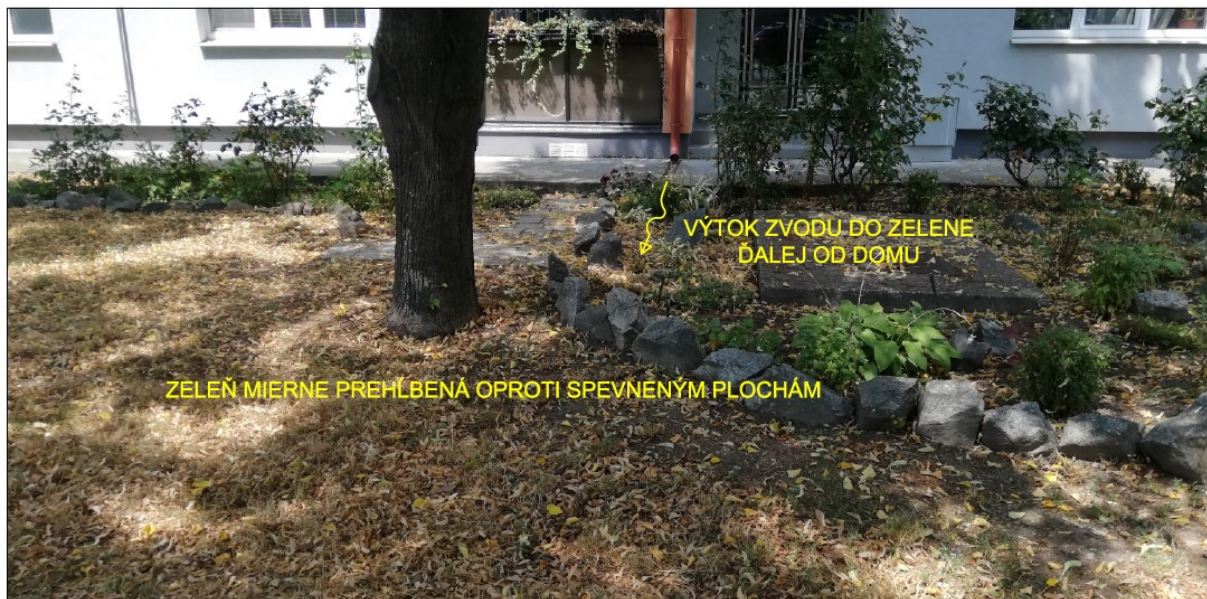
Obr. č.3 – Príklad správneho odvodnenia so strešnými zvodmi pri bytových domoch do zelene v meste Senec
