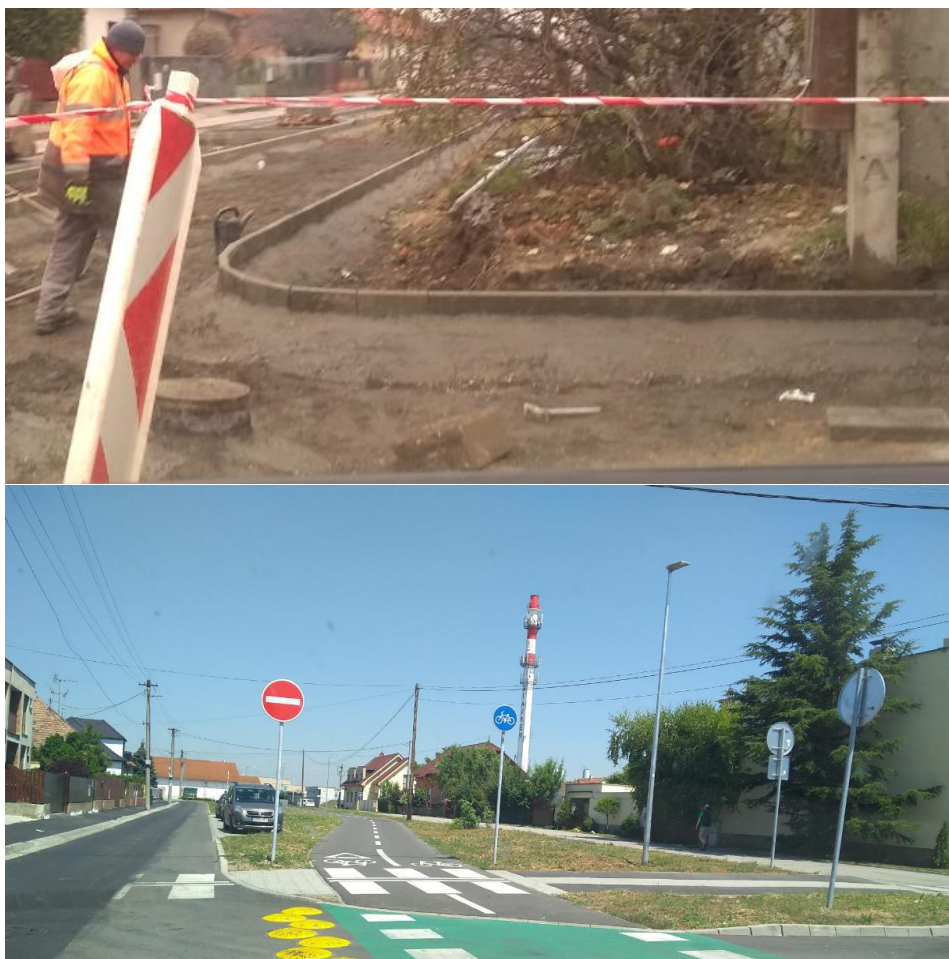
Obr. 2.32 Práce na cyklocestičke Hečkova december 2019 (hore) a už po výstavbe 2020 (dole)
