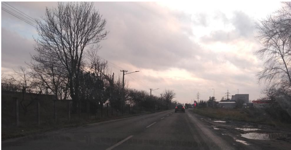
Obr. 2.31 Chýbajúce chodníky na ul. Šamorínska
