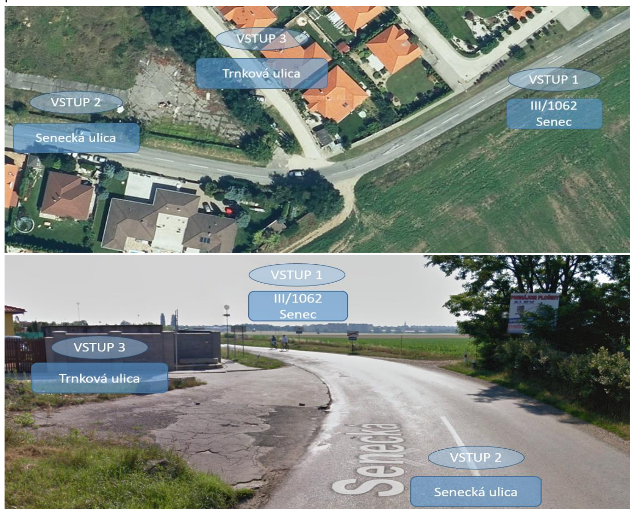
Obr. 2-3 Lokalizácia a usporiadanie vstupov na riešenej križovatke K1 pre potreby vyhodnotenia DP
