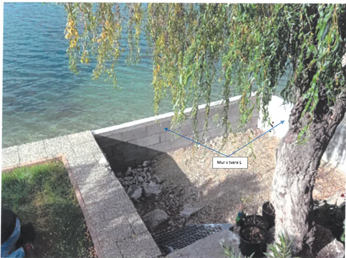
V. Horák vybudoval múr v tvare L a pripojil sa priamo na bočný deliaci múr poškodenej.
