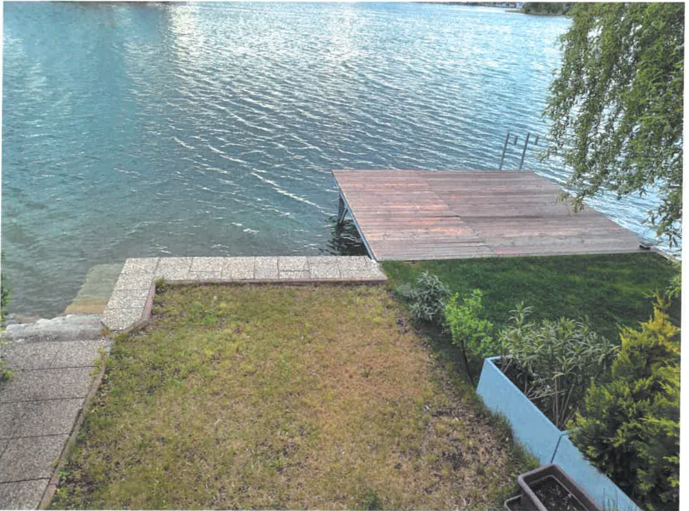
Obr. 2 Stav spevnenej plochy poškodenej po stavebnom zásahu V. Horáka (dátum Jún 2023)
